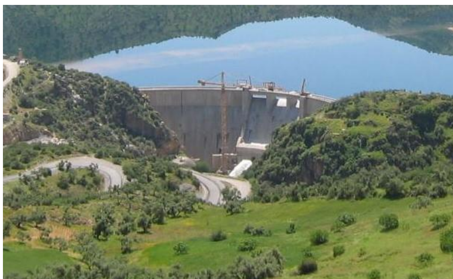
Figure 2.1 : Barrage Tichy Haf : Vue direct de barrage
