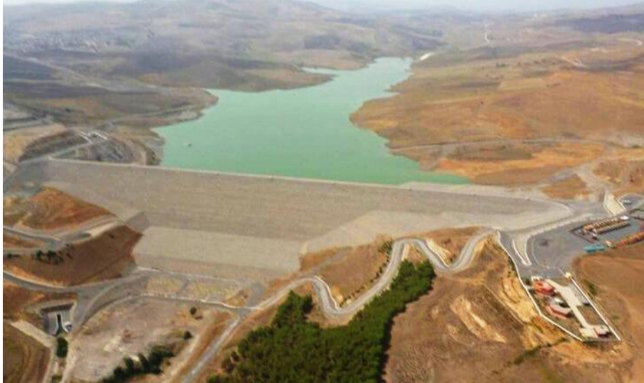
Figure 2.16 : L'aménagement du barrage de Mahouane
