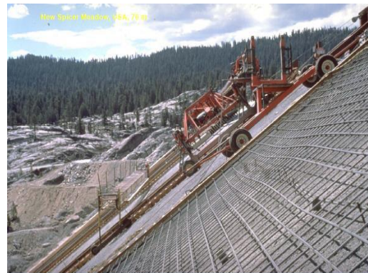
Figure 1.7: Masque en béton armé (barrage New Spicer Meadow, USA)
