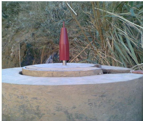
Figure 2.17 : Piliers de planimétrie
