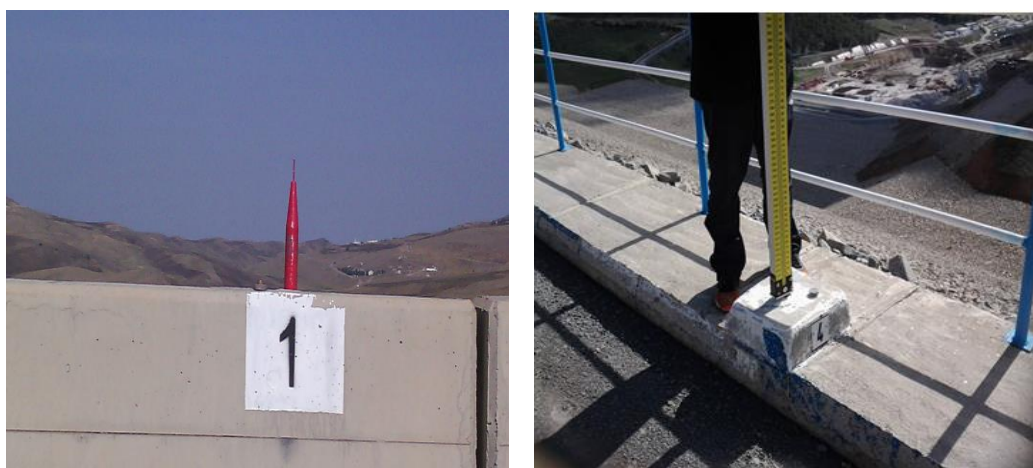
Figure 2.24 : Repères de déformation
