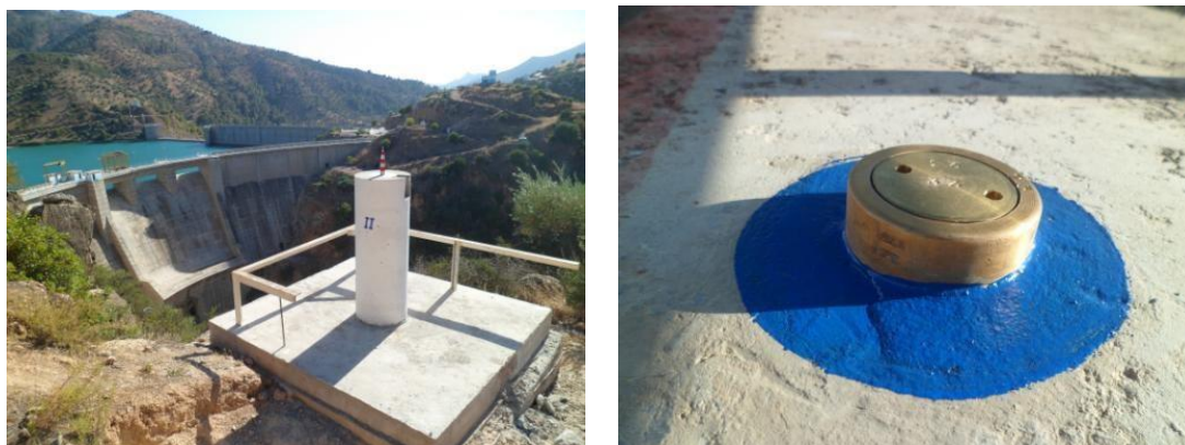
Figure 2.9 : Piliers de Planimétrie
