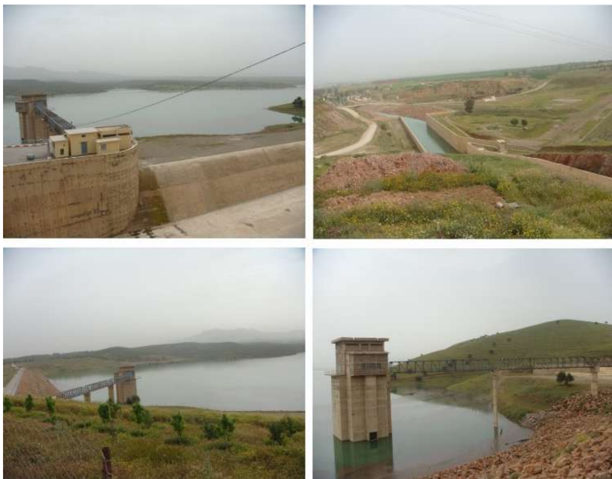
Figure 4.6. Vue panoramique du barrage d'Ouled Mellouk
