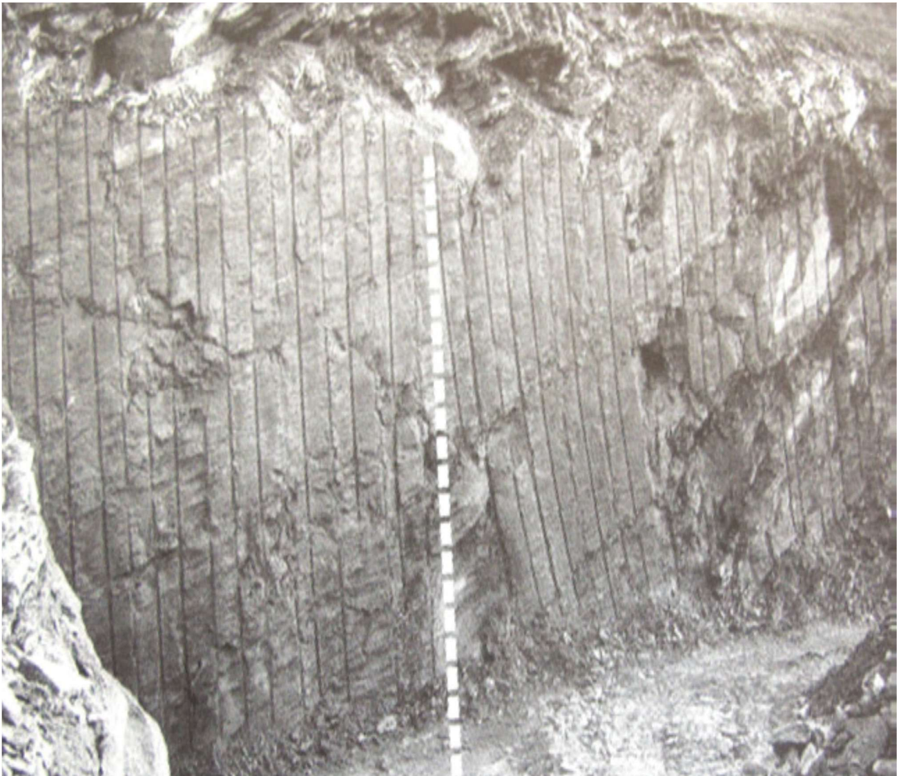
Figure 1.12. Déviation naturelle des forages causée par les strates du terrain (à gauche: avec tige guide pour limiter les déviations; à droite: sans tige guide). D'après Meyer, 2002 [31]
