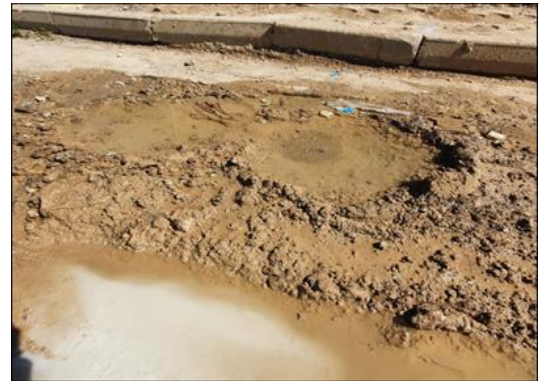
Photo 3.4. Fuites dans les réseaux de distribution
