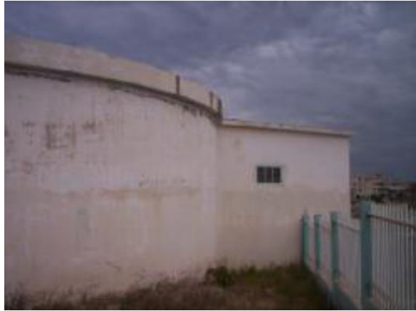
Réservoir Oued Forcha
