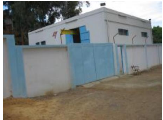
Station Sidi Harb nouveau
