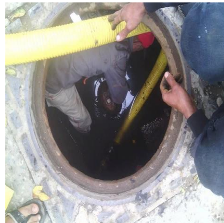
Photo 1.4. Fuites sur équipements de réseau
