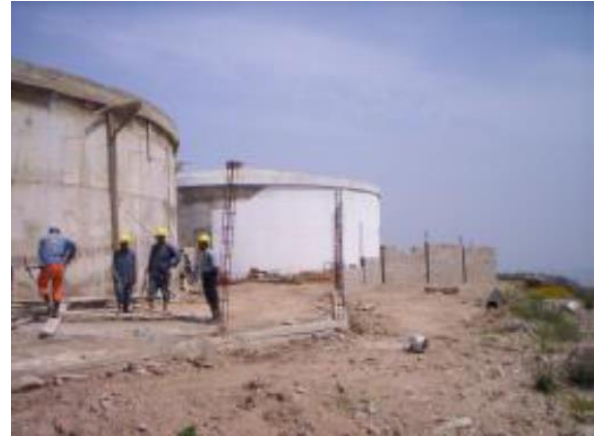
Réservoir Sidi Achour
