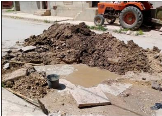
Photo 3.4. Fuites dans les réseaux de distribution
