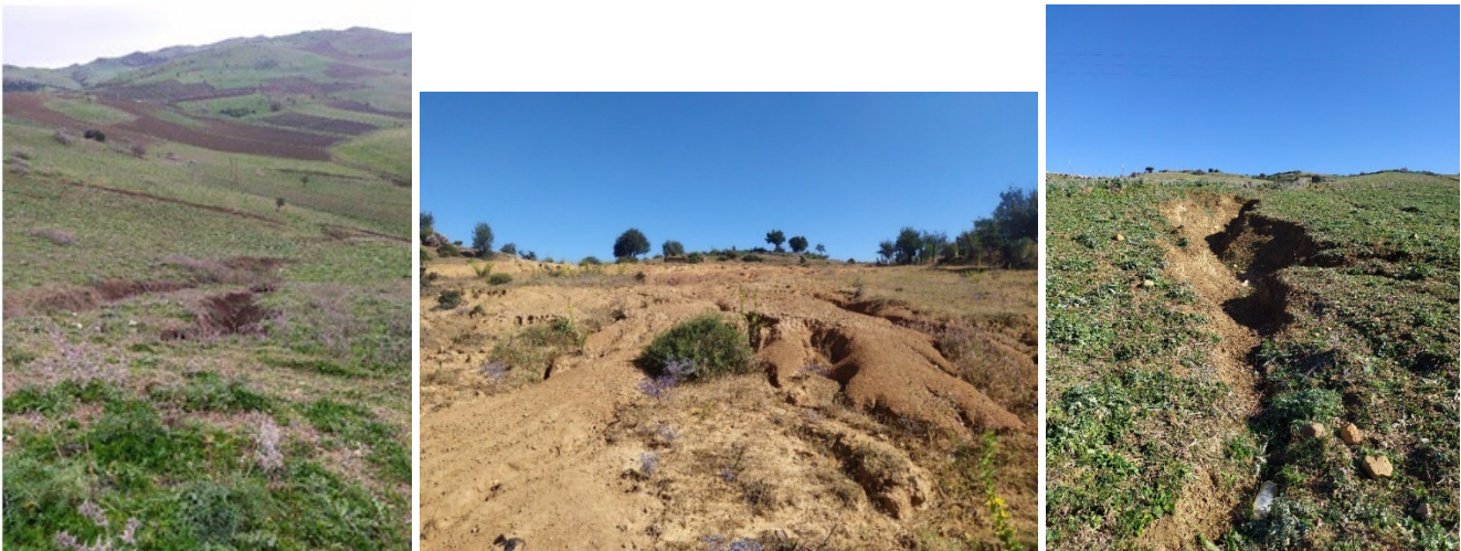
Figure 3. Photos montrant l'érosion en rigoles dans le bassin de l'Oued Rhirane.
