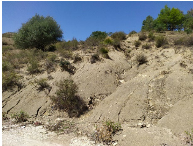
Figure 2. Erosion par griffes dans le bassin versant de l'Oued Rhirane.
