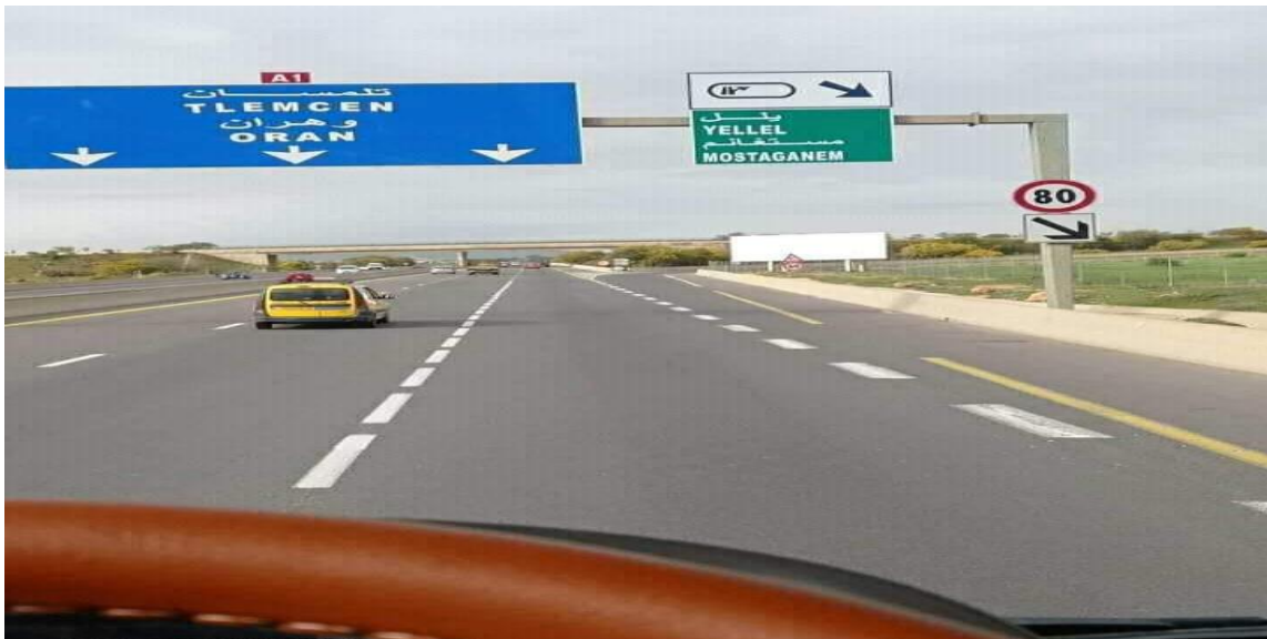
Figure 3.3. L'entrée de l'autoroute avec limitation 80Km/h.
