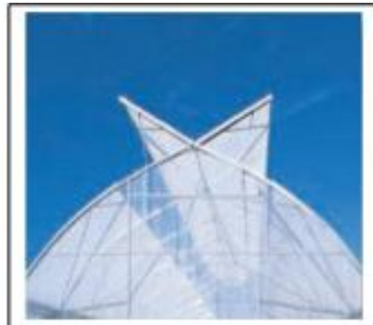
Fig. 1.11. Ventilation par deux cotés
