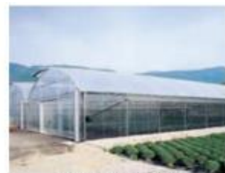
Aération latérale par enroulement avec filet brise-vent et mécanisme d'extrémité.
