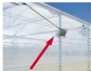
Aération latérale par enroulement, mécanisme central.
