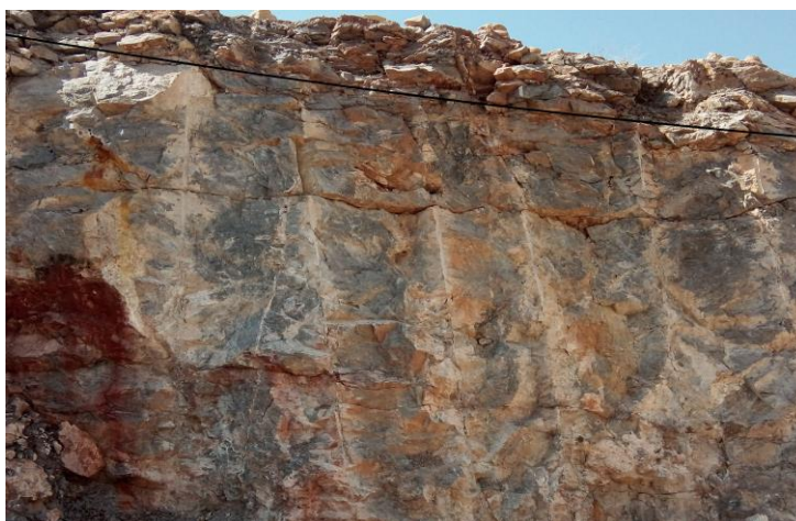
Fig. IV.5. Zone non régulée excessivement fissurée.
