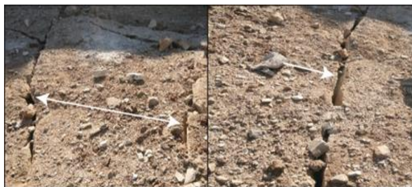
Fig. IV.13. Fissures créées après le tir (effets arrière).
