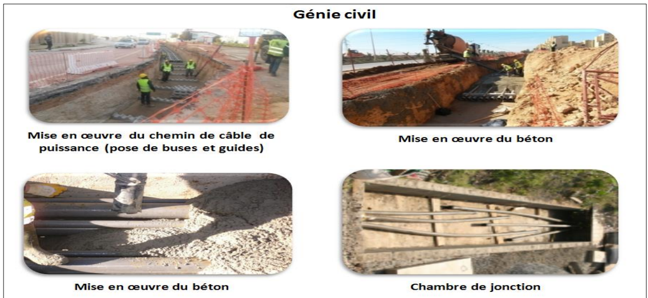
Figure 5.31. Travaux de génie civil du câble électrique sous terrain [58] [81].
