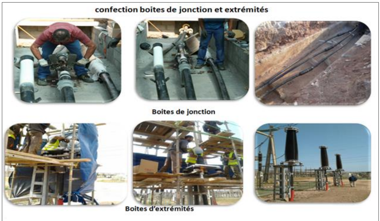
Figure 5.32. Travaux de confection des boîtes de jonction des câbles Électrique [58] [81].
