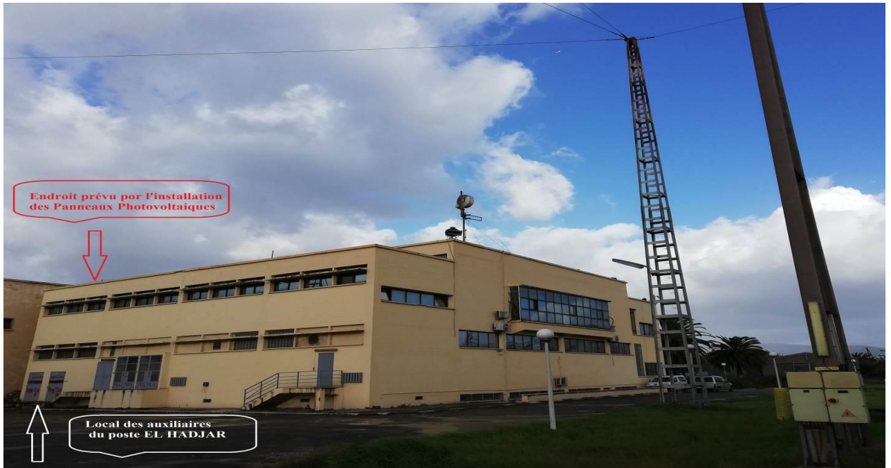
Figure 3.18. Bâtiment de Commande poste 220/90/60/30kv EL HADJAR [54].
