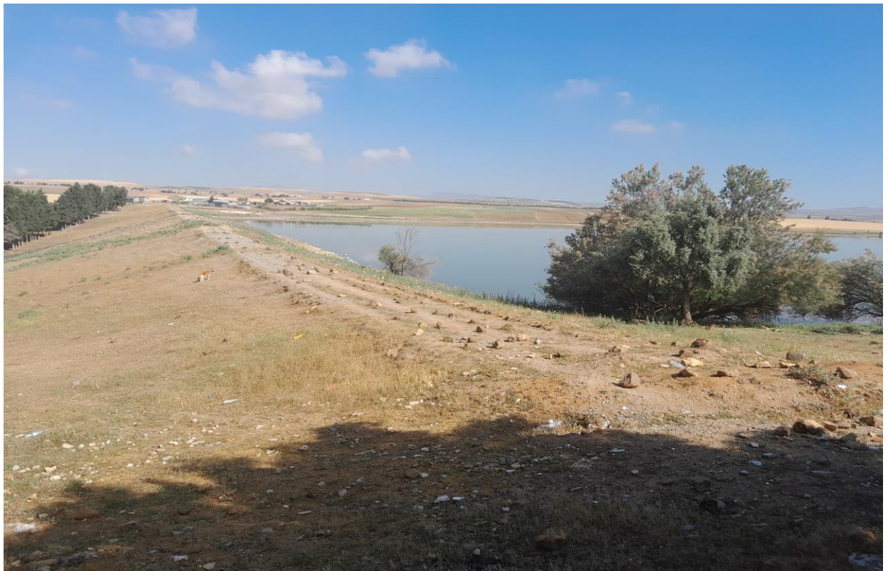
Figure IV. 2 Vue direct du site du barrage
