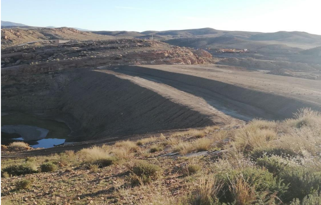
Figure I. 9 Barrage a masque amont (Sidi Aissa, W.Ms'ila) en cours de réalisation.
