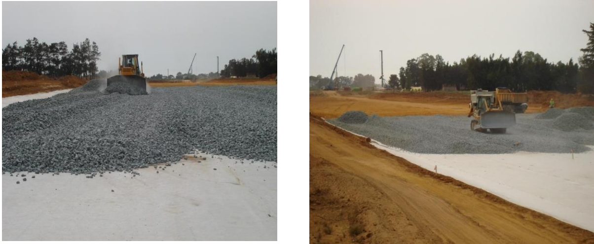
Figure II. 7 Séparation par géotextile (Rocade sud d'Alger)
