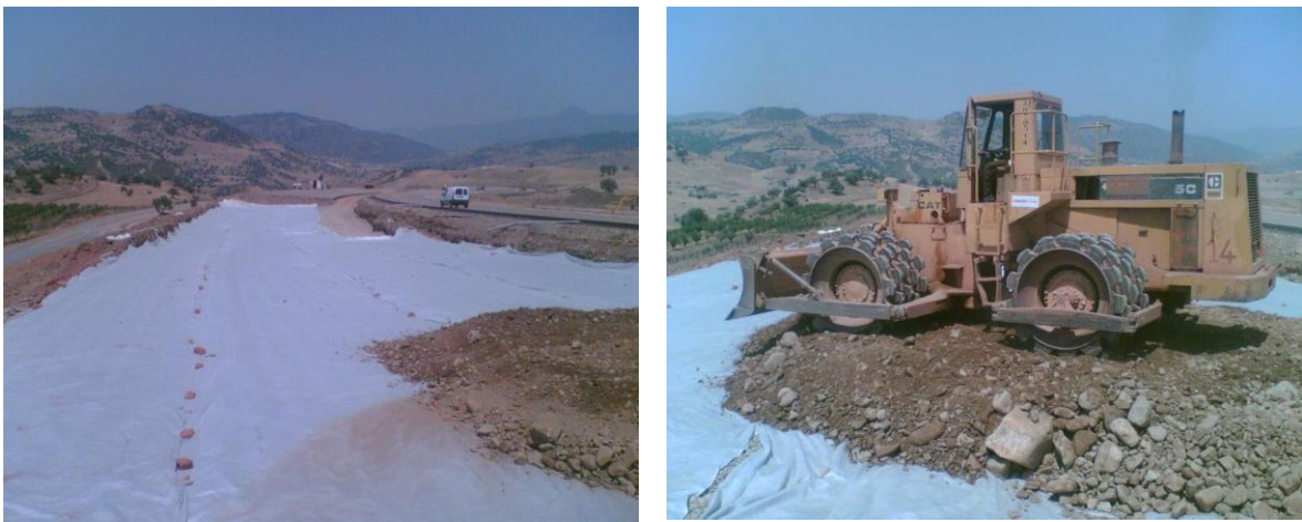
Figure II. 6 Séparation par géotextile (Contournement de Bouira)
