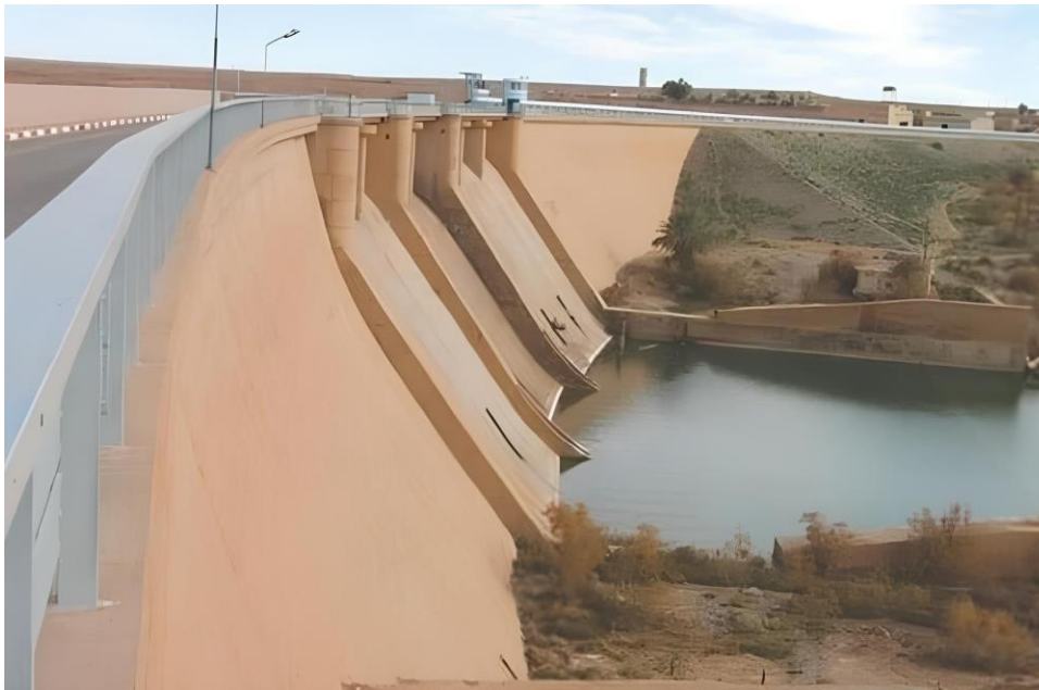
Figure I. 1 Barrage Djorf Torba ( W. Béchar).
