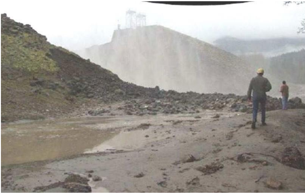
Figure I. 13 Etat final de la rupture du barrage de Swift
