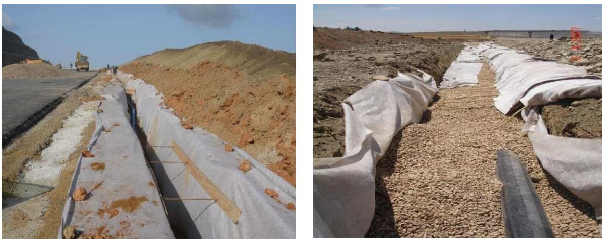
Figure II. 8 Filtration par géotextile (Autoroute Est/Ouest)
