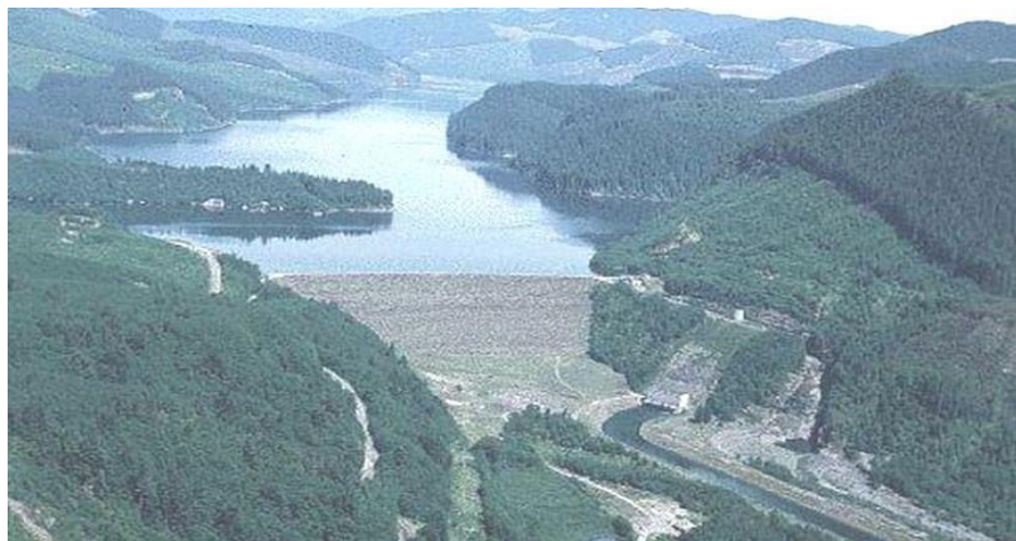
Figure I. 11 Barrage de Swift aux USA avant la rupture
