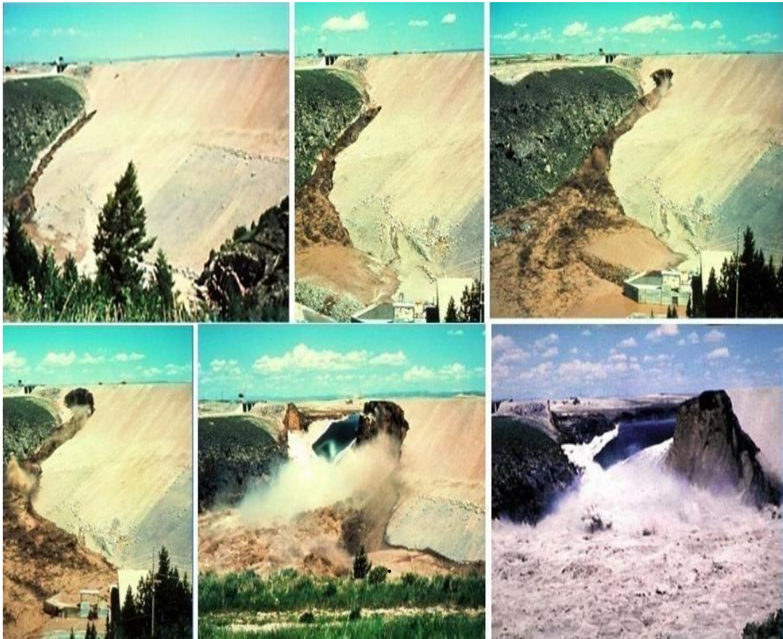
Figure I. 14 Les différents étapes de rupture du barrage Teton
