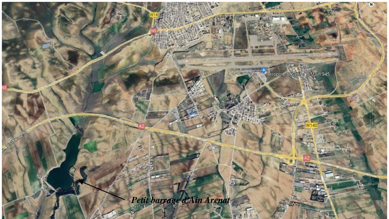
Figure IV. 1 Vue arienne du site du barrage.(Image satellitaire par Google Earth)
