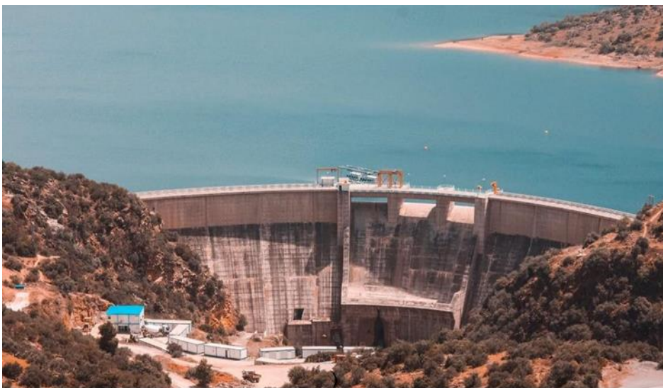
Figure I. 4 Barrage Tichi haf (W. Bejaïa)
