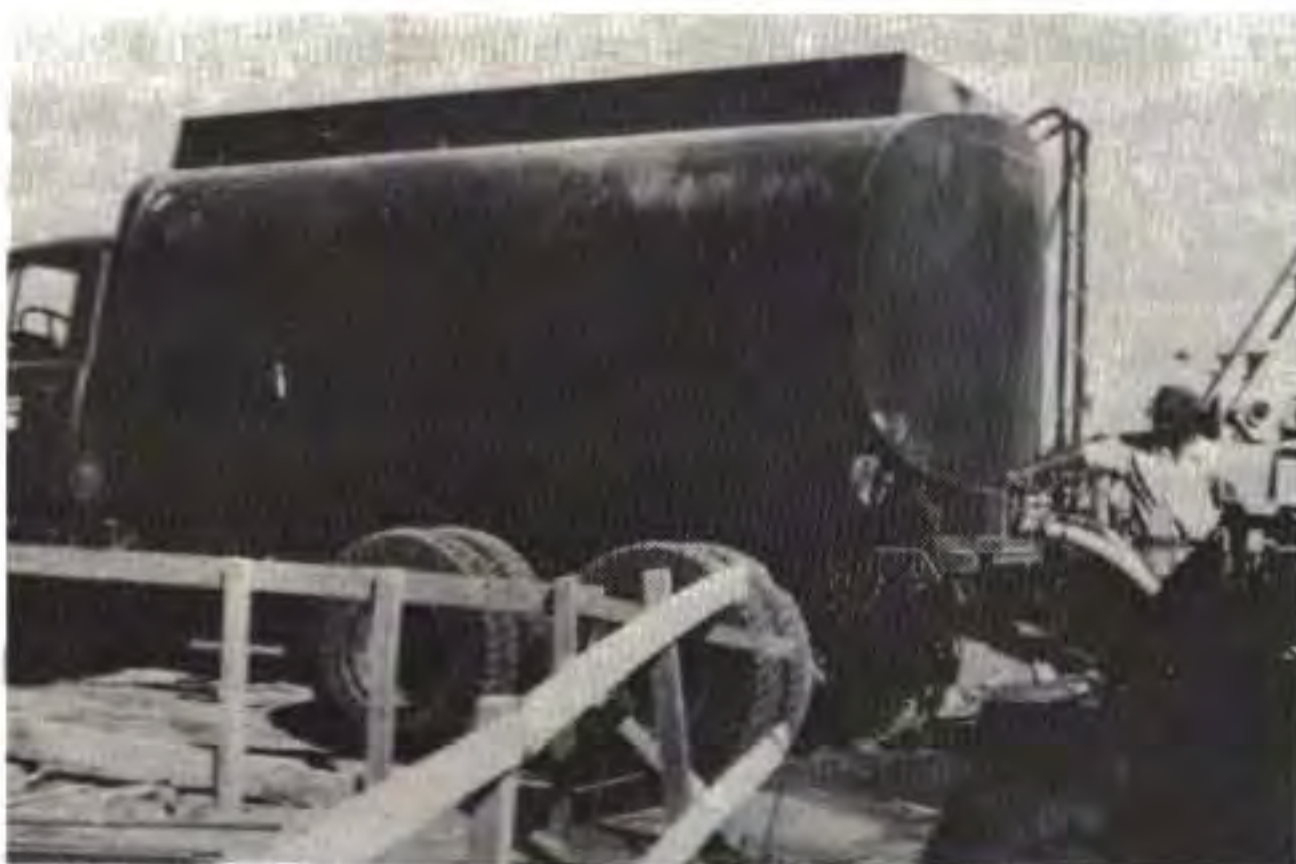
FIG. 103. — Transport de l'eau de mer dessalée jusqu'au chantier (doc. S.A.E.).
