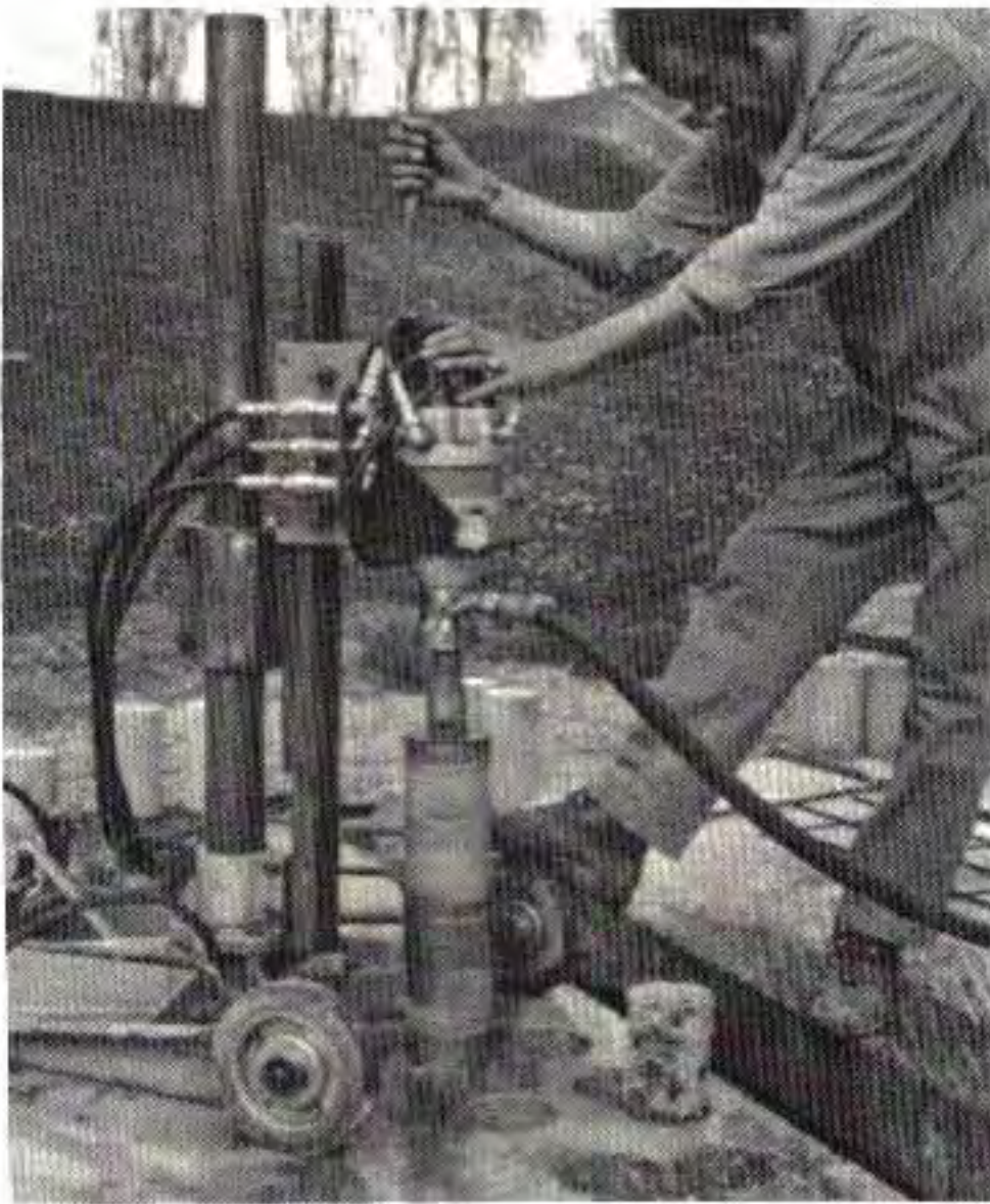
FIG. 81. — Opération de carottage avec machine hydraulique (doc. C.E.B.T.P.).
