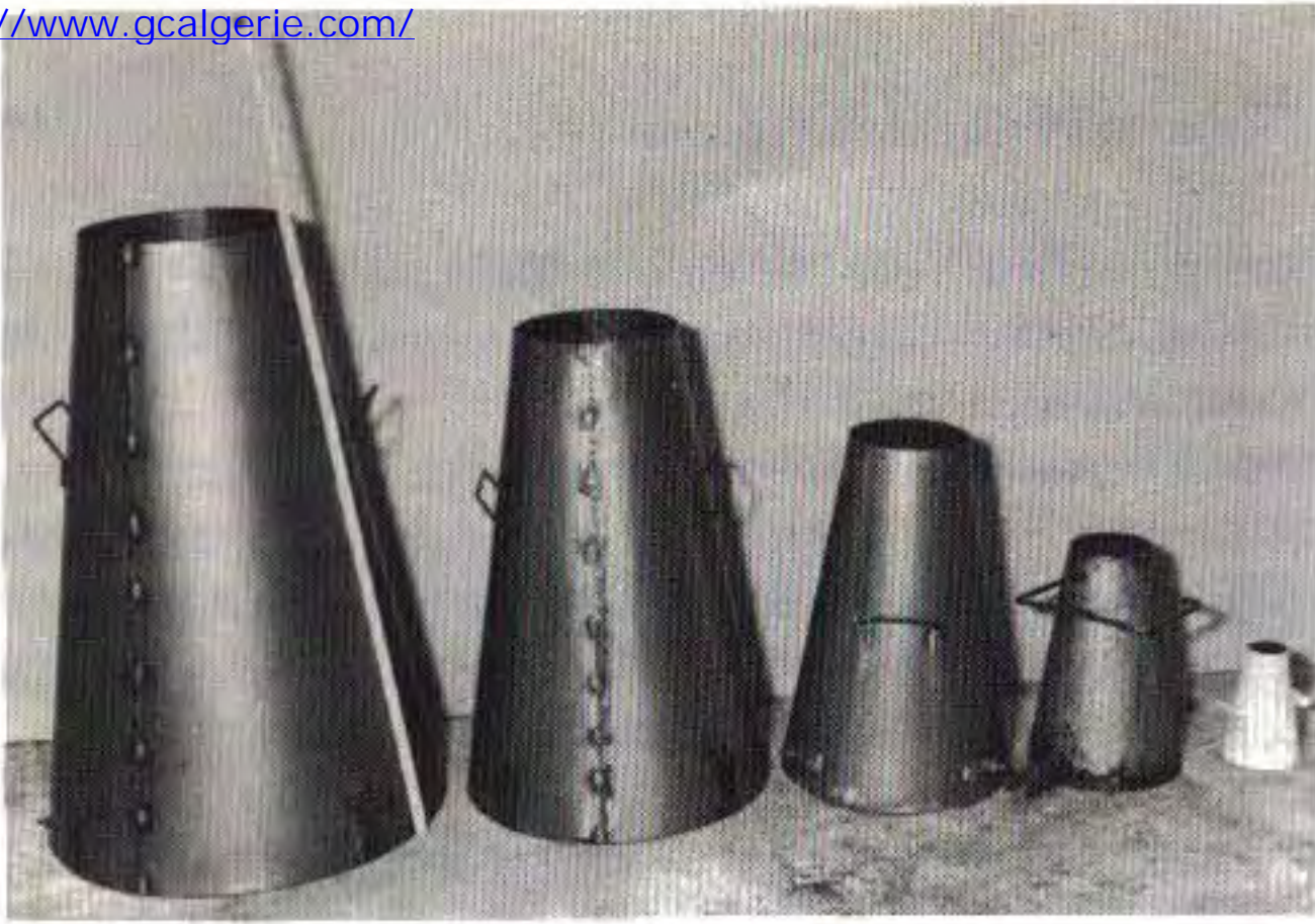
FIG. 39. — Cônes employés pour la mesure de consistance (hauteur maximale 75 cm).
