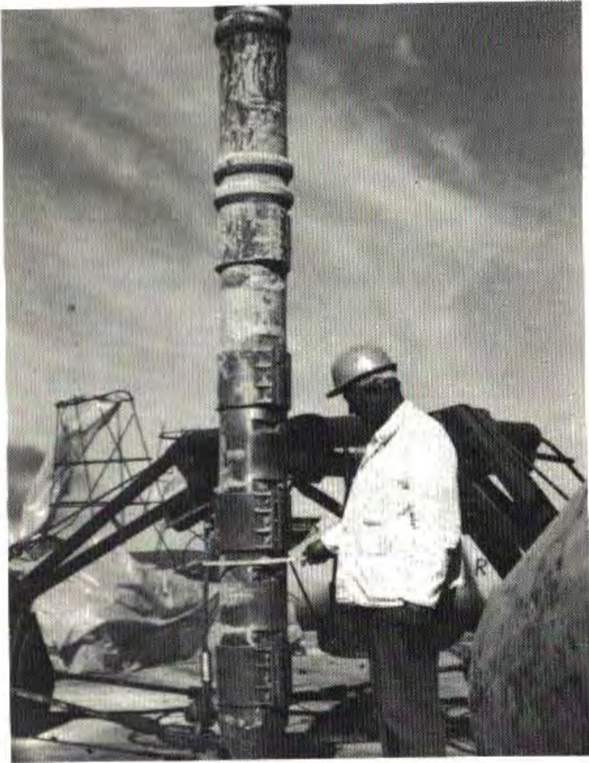
FIG. 31. — Vibreur interne de type « aiguille » de grande dimension déplacée à l'aide de la grue (diamètre 300 mm).
