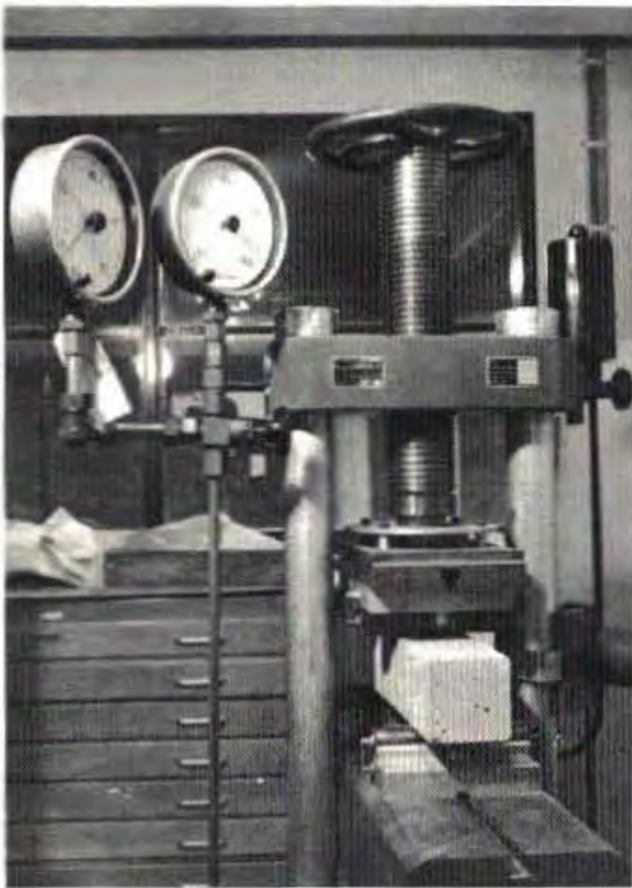
FIG. 58 bis. — Machine de flexion de 150 KN (~ 15 T).
