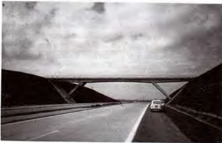
Fig. 3.28 - Le mécanisme de la structure de ce pont est bien affirmé (Autoroute A7) (photo SETRA).
