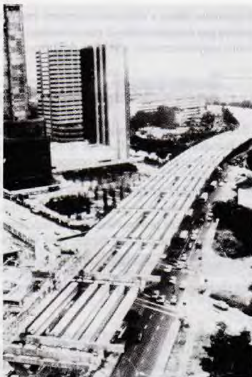
Fig. 4.10 - Viaduc de l'Ayer Rajah à Singapour (photo GTM).
