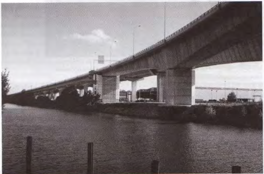
Fig. 3.22 - Pile-culée entre le viaduc et le pont de Gennevilliers (photo JAC).
