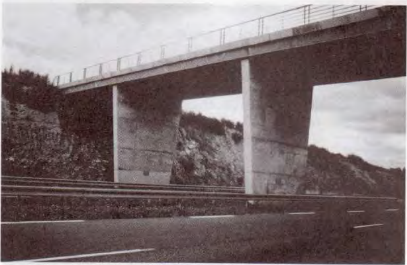
Fig. 3.7 - Proportions maladroites des ouvertures et des piles par rapport au tablier (photo SETRA).
