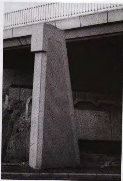
Fig. 3.29 - Une forme de pile qui exige un soin particulier à l'exécution (photo SETRA).
