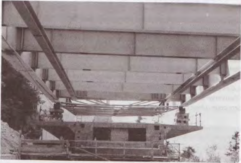
Fig. 7.34 - Ossature métallique en cours de lancement avec un avant-bec (photo JAC).
