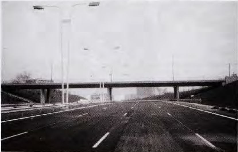
Fig. 3.2 - Un ouvrage aux bonnes proportions (Autoroute B3) (photo SETRA).
