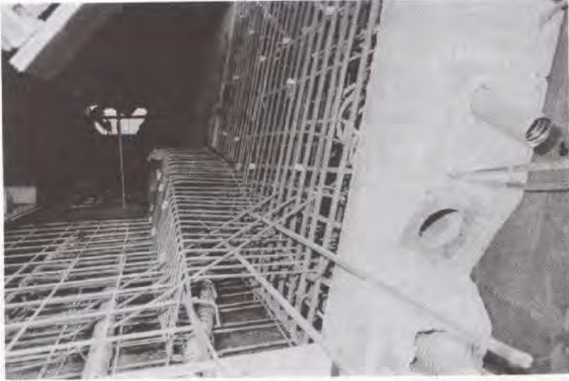
Fig. 5.10 - Ferrailage d'un bossage d'ancrage d'un câble de continuité (photo JAC).
