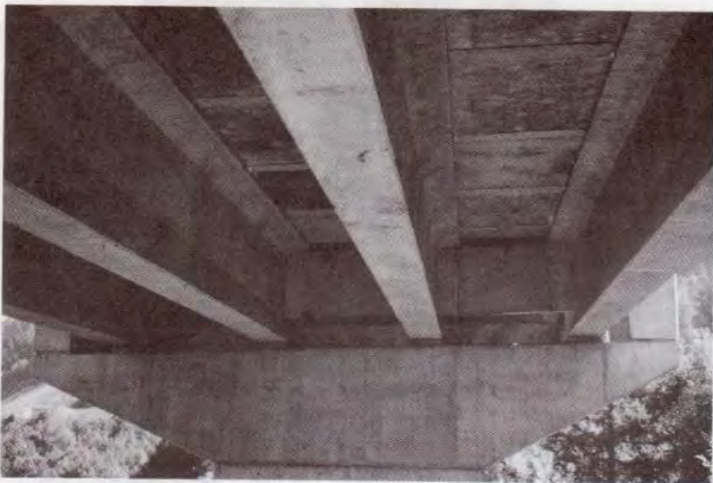
Fig. 4.8 - Vue de la poutraison et de l'entretoise d'about (photo JAC).
