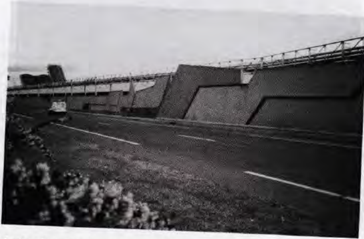
Fig. 3.36 - Mur de grande longueur (usines Michelin à Clermont-Ferrand). L'animation des parements atténue la longueur du mur et donne un rythme à la structure (photo A.B.-G.).
