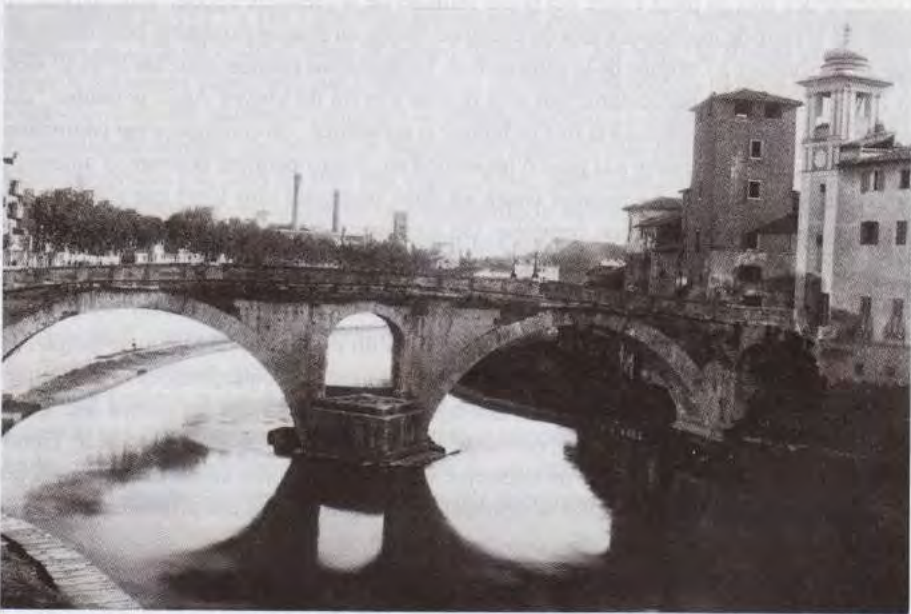
Fig. 1.6 - Pont Quattro Capi à Rome (Arch. Alinari).
