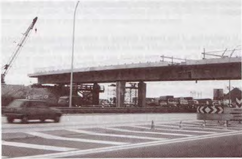
Fig. 6.1 - Exemple de pont poussé bilatéralement sur l'autoroute A6 (photo JAC).
