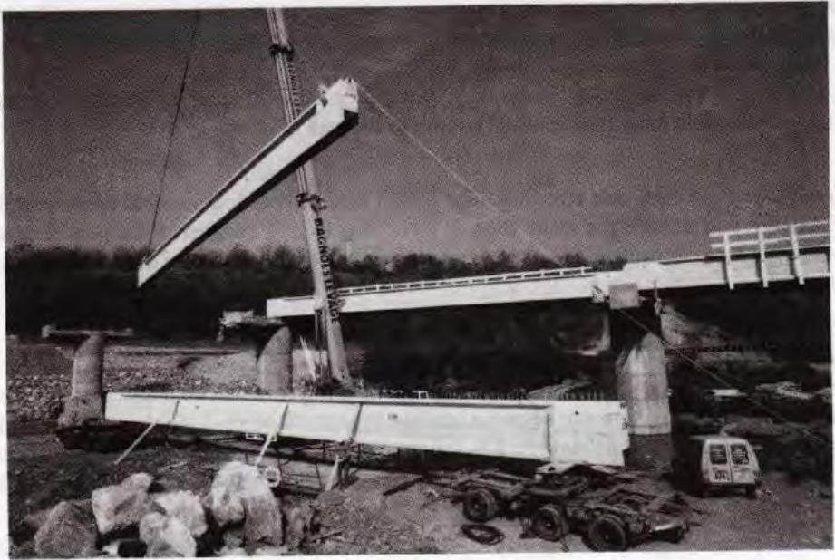
Fig. 4.15 - Poutres précontraintes en cours de manutention (photo PPB-SARET).
