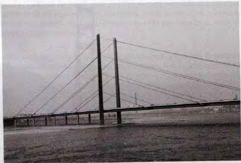
Fig. 1.22 - Pont à haubans de Kniebrücke à Düsseldorf (photo JAC).
