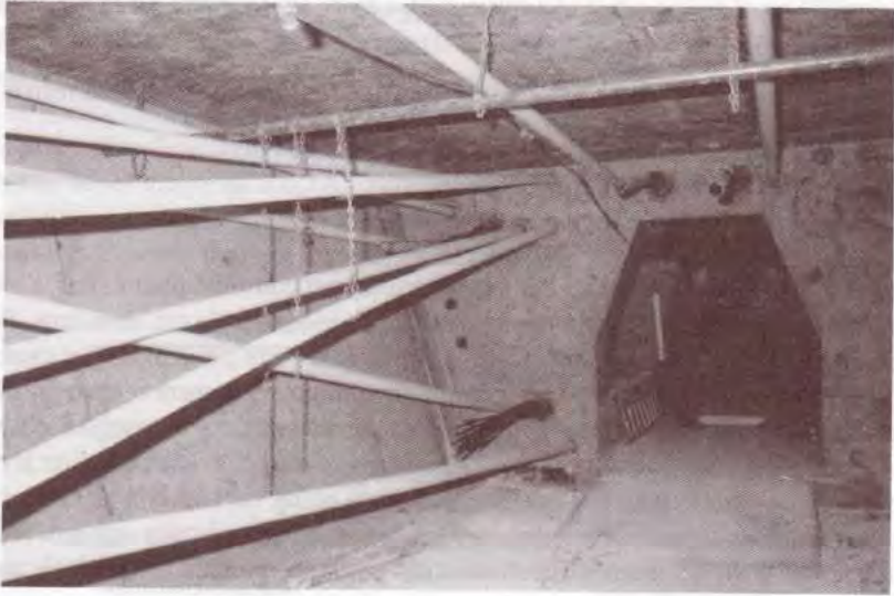
Fig. 6.6 - Câblage du viaduc Jules-Verne près d'Amiens (photo Campenon-Bernard).
