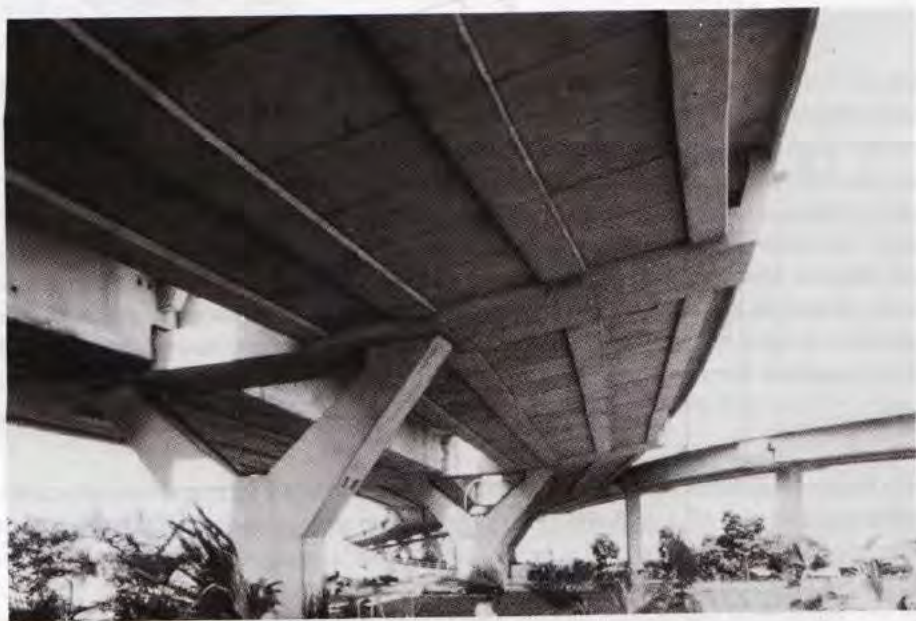
Fig. 4.14 - Viaduc de l'Ayer Rajah à Singapour - Vue de dessous (photo GTM).
