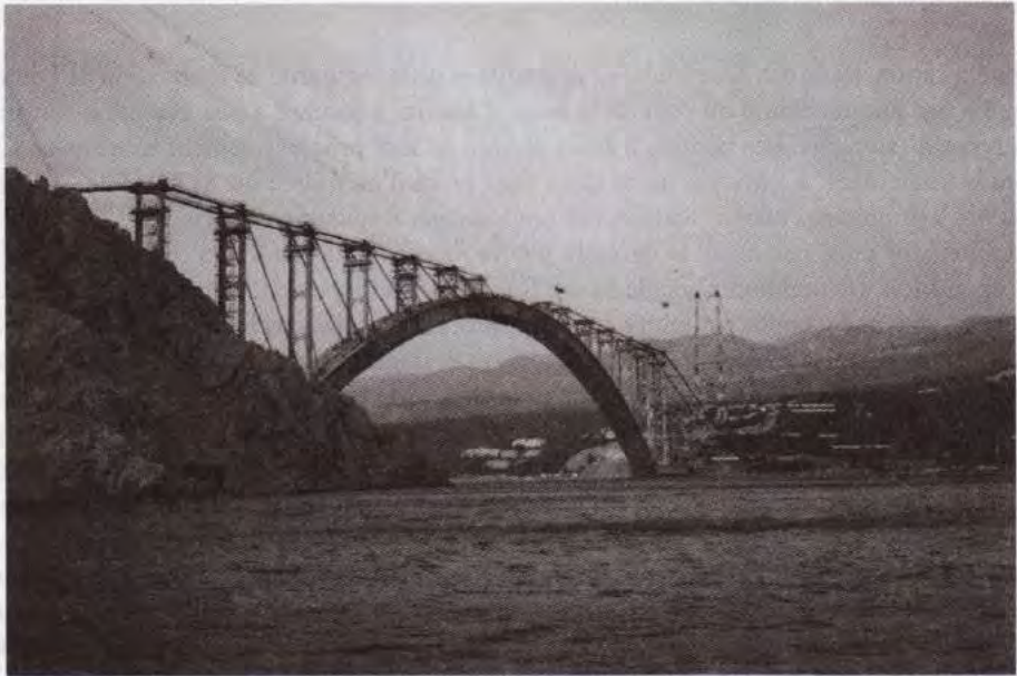
Fig. 1.18 - Pont de Krk en ex Yougoslavie, en construction (photo JAC).
