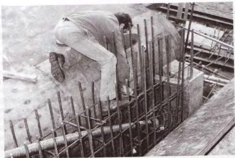
Fig. 5.8 - Pont d'Amboise sur la Loire - Câble "descendant" dans une âme (photo JAC).
