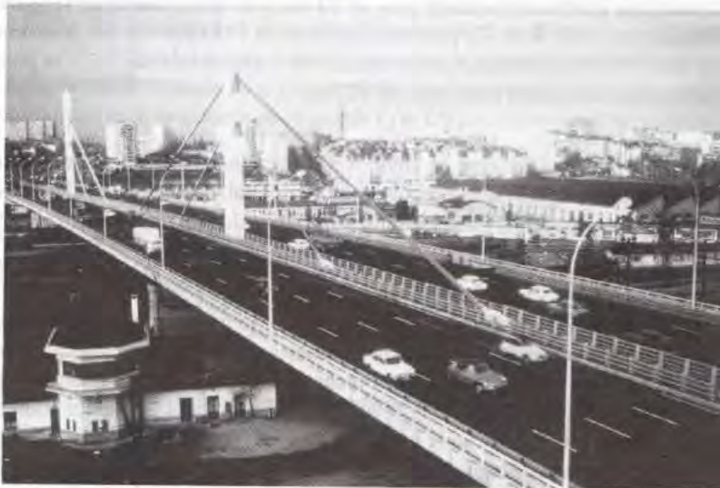
Fig. 8.3 - Pont Masséna sur le Boulevard périphérique de Paris (photo SETRA).
