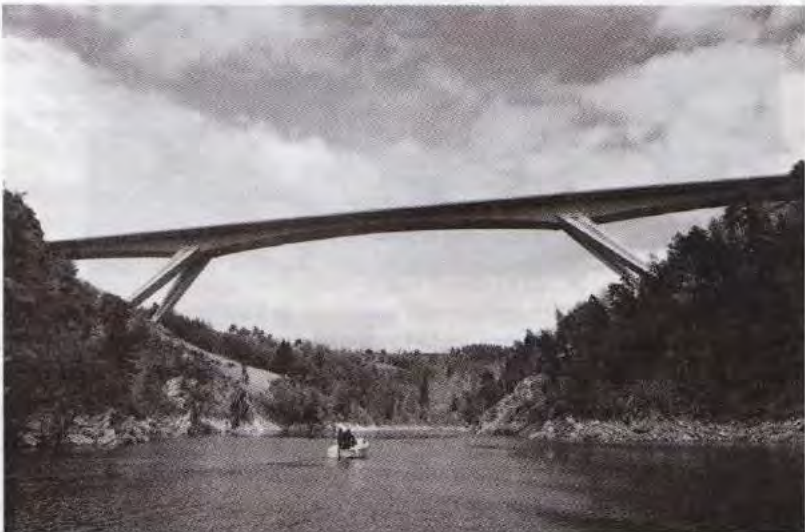
Fig. 3.13 - Pont sur la Truyère. On remarquera l'évolution des techniques (photo DDE Cantal).
