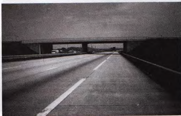
Fig. 3.26 et 3.27 - La succession de ces deux types d'ouvrages sur un tronçon donné d'autoroute n'est pas souhaitable (photos SETRA).
