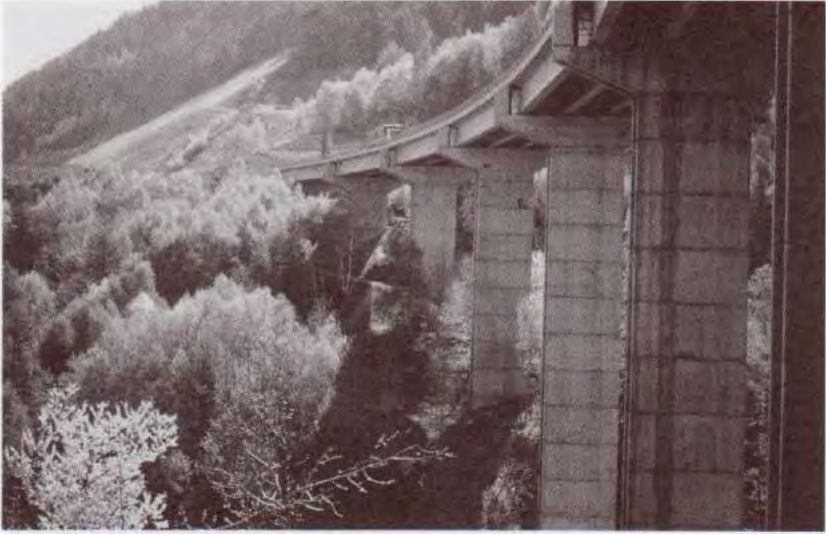
Fig. 3.3 - La forme et les proportions des piles donnent une bonne impression de stabilité (photo SETRA).
