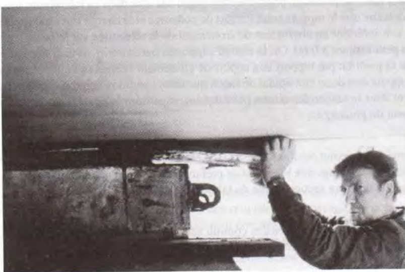
Fig. 6.17 - Introduction des plaques de glissement (photo JAC).
