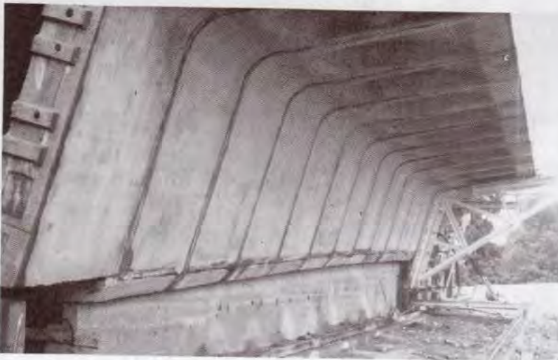
Fig. 5.22 - Vue d'un banc de préfabrication (photo JAC).
