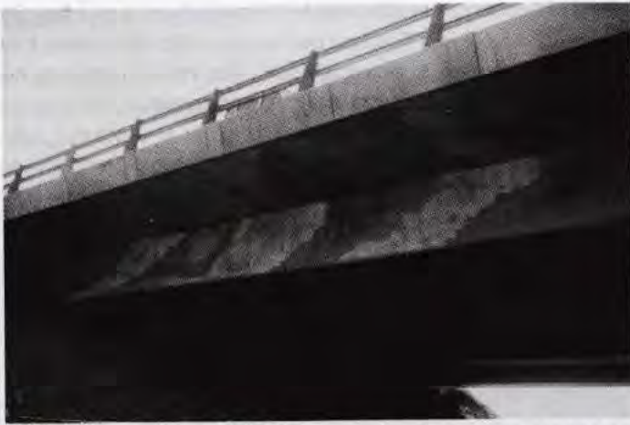
Fig. 3.37 - Les gâchées de béton n'avaient pas la même provenance (photo SETRA).
