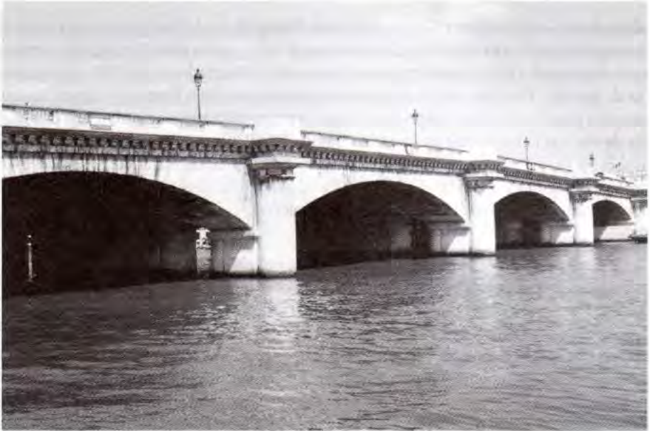
Fig. 1.11 - Pont de La Concorde à Paris (photo JAC).
