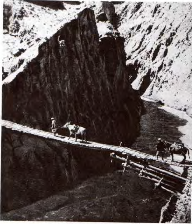
Fig. 1.1 - Pont en bois en Inde (photo SETRA).
