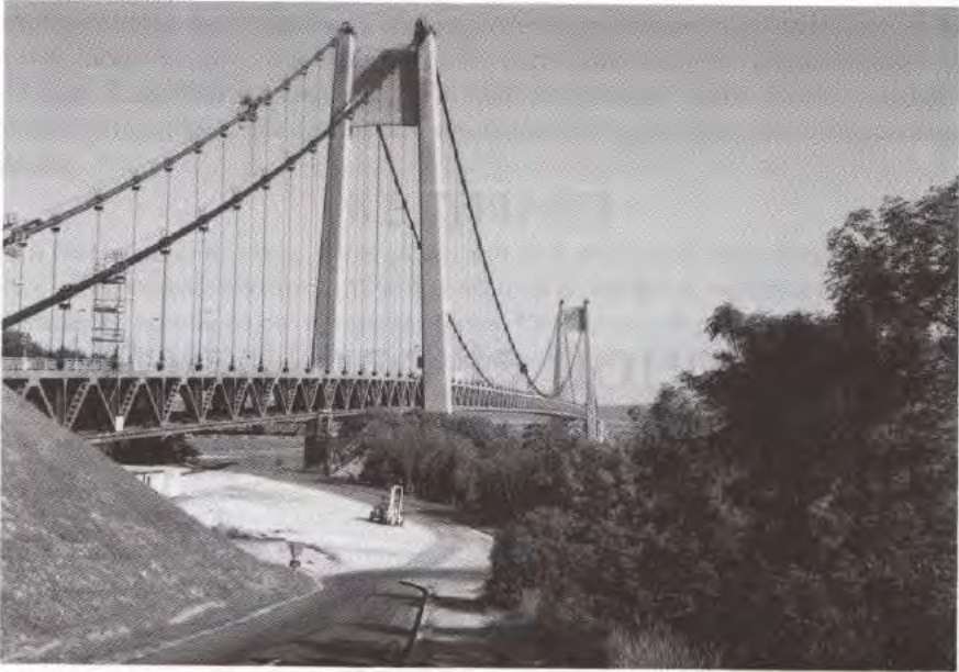
Fig. 8.1 - Vue du pont de Tancarville sur la Seine (photo JAC).
