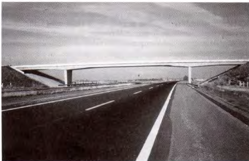
Fig. 3.10 - Un ouvrage qui dégage particulièrement bien l'espace (autoroute A13) (photo SETRA).
