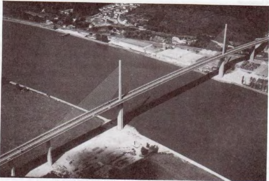
Fig. 1.24 - Pont de Brotonne sur la Seine (photo Campenon-Bernard).
