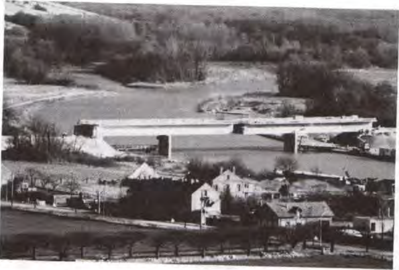
Fig. 6.4 - Pont (ferroviaire) poussé sur la Seine près de Melun (photo GTM).
