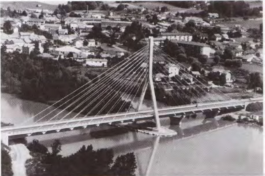
Fig. 3.16 - Vue aérienne du pont de Seyssel (photo G. Forquet).
