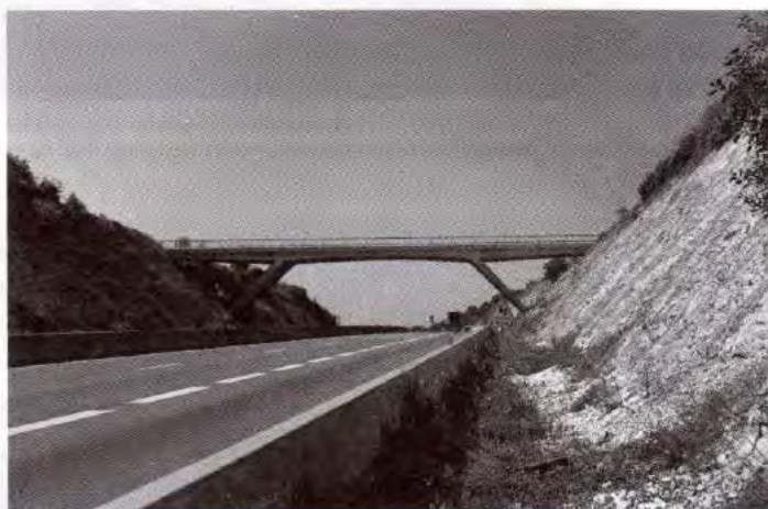
Fig. 3.11 - Pont à béquilles marquant un point haut de l'autoroute A6 (photo JAC).
