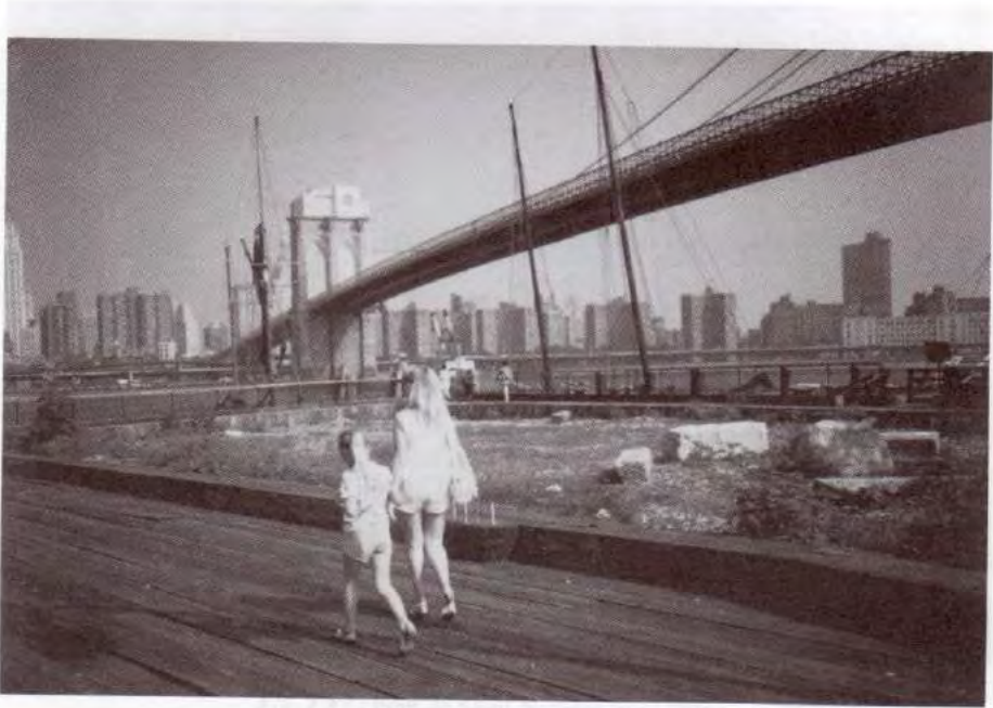
Fig. 1.19 - Pont de Brooklyn à New York (photo J.M. Conte).
