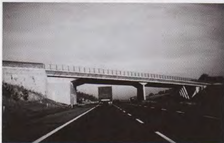
Fig. 3.24 - Ouvrages disgracieux (photo Slater).
