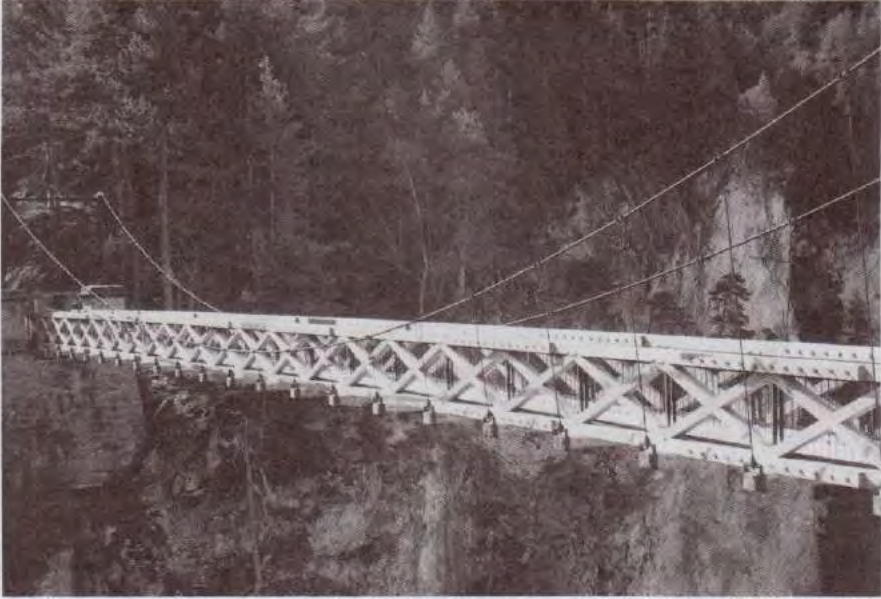
Fig. 1.3 - Passerelle suspendue en bois (Savoie) (photo JAC).
