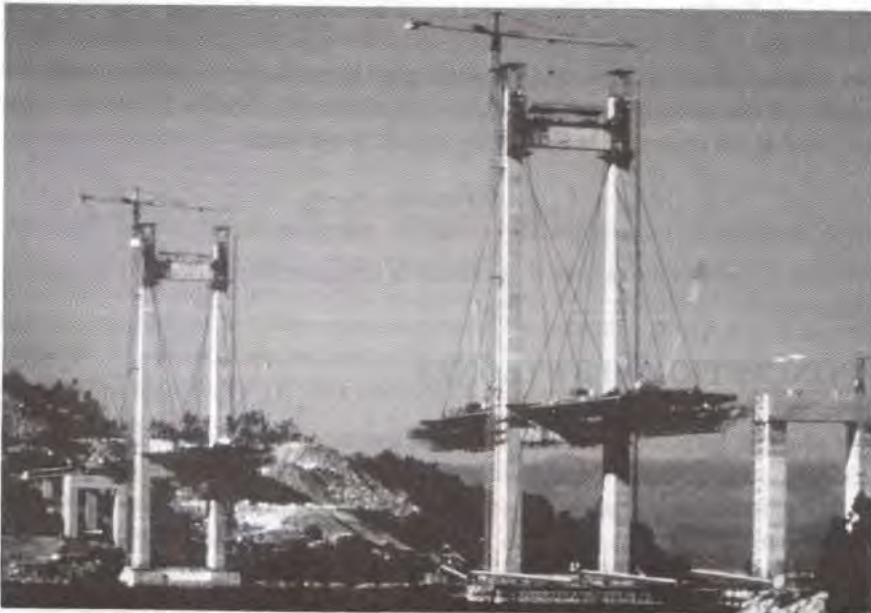
Fig. 8.9 - Vue des pylônes du pont de Rande en Espagne (photo SETRA).
