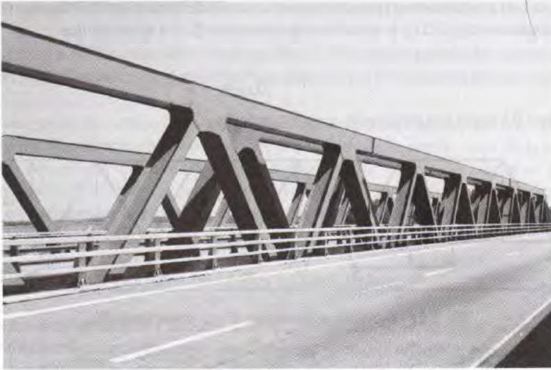
Fig. 7.20 - Pont sur l'autoroute A36 (photo JAC).
