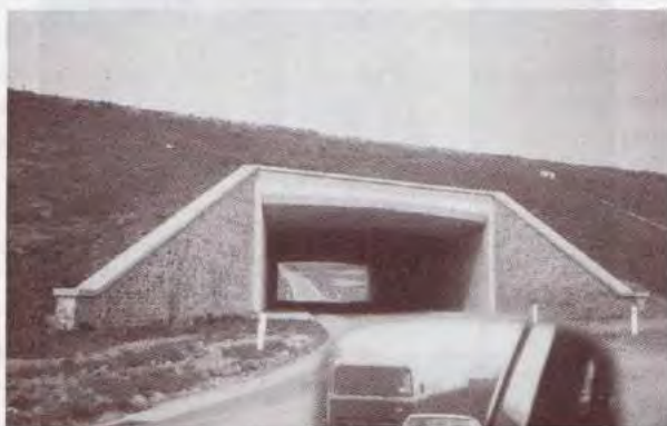
Fig. 3.31 - Un petit ouvrage particulièrement réussi (photo SETRA).
