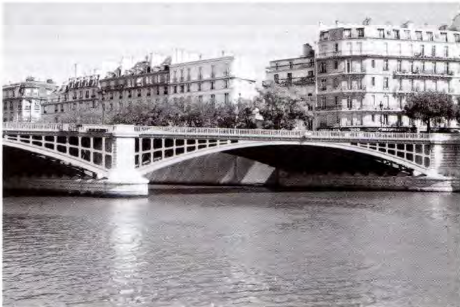
Fig. 1.12 - Le pont Sully à Paris (photo JAC).
