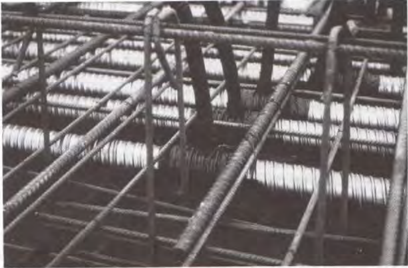
Fig. 5.24 - Fixation d'évents sur les conduits de précontrainte (photo JAC).
