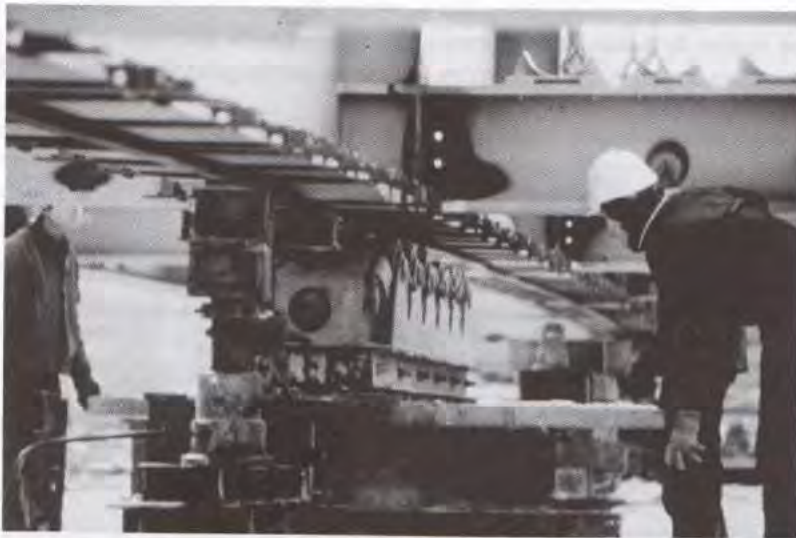
Fig. 7.33 - Pont d'Issy-les-Moulineaux. Lançage de l'ossature métallique (photo ABG).
