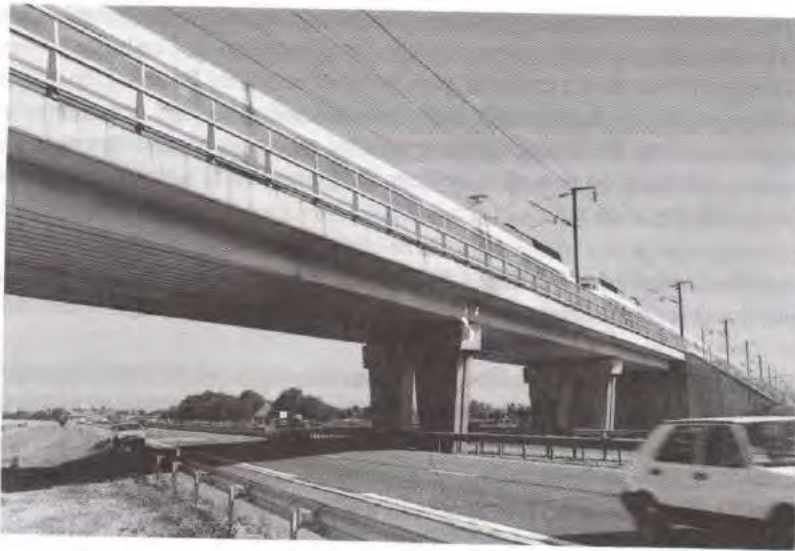
Fig. 7.10 - Pont à poutrelles enrobées sur l'autoroute A6 (photo JAC).
