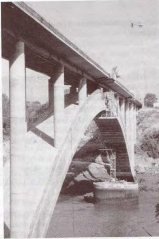
Fig. 5.26 - Pont en arc sur la Rance à tablier en ossature mixte (photo Campenon-Bernard).
