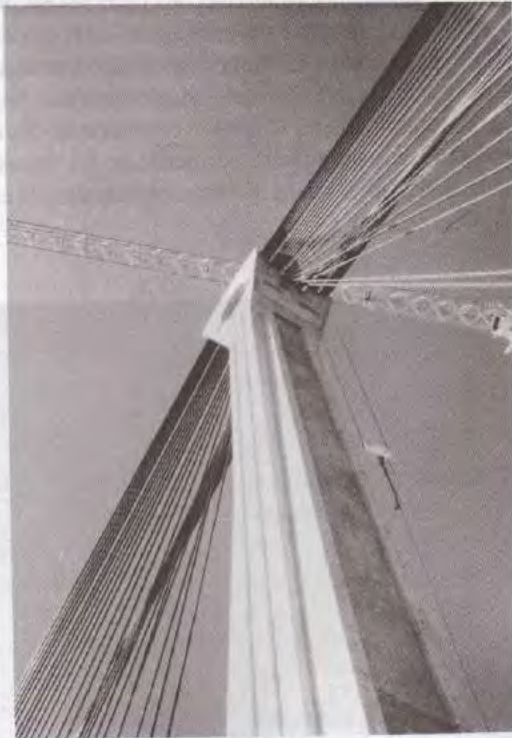
Fig. 8.23 - Tête de pylône du pont sur l'Isère (photo JAC).
