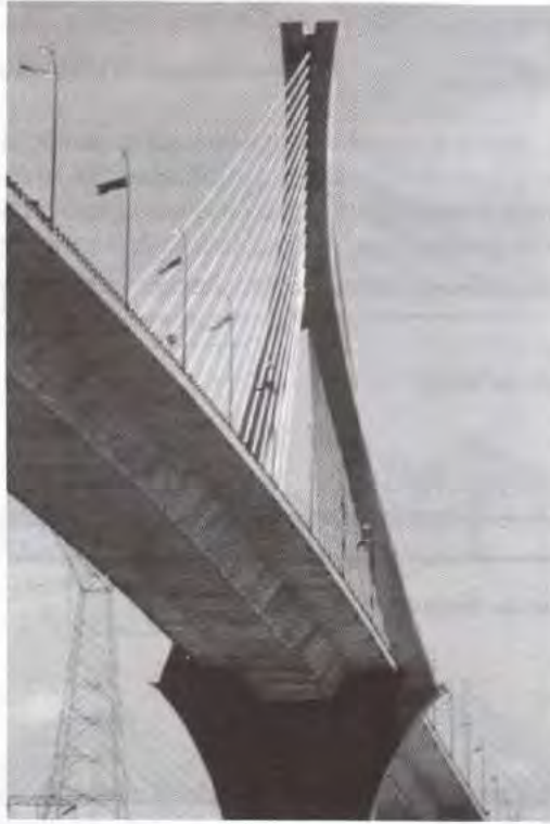
Fig. 8.11 - Vue du pont de Coatzacoalcos II au Mexique (photo J.-P. Duée).
