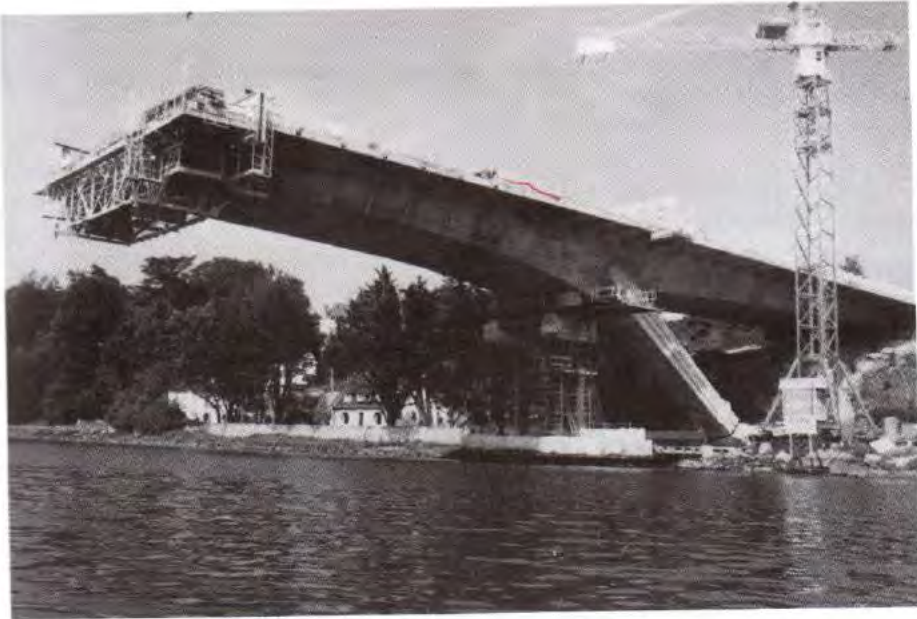
Fig. 5.31 - Construction du pont d'Auray (photo G. Forquet).
