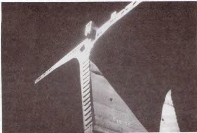
Fig. 5.21 - Voussoir doté de clés multiples (photo JAC).
