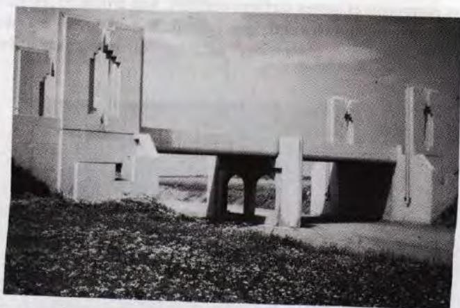
Fig. 3.34 - Ouvrage sur l'autoroute A61 - L'ornement et les équipements ne sont pas à l'échelle de l'ouvrage (photo SETRA).
