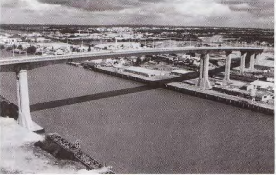
Fig. 3.15 - Le pont de Cheviré (photo G. Forquet).
