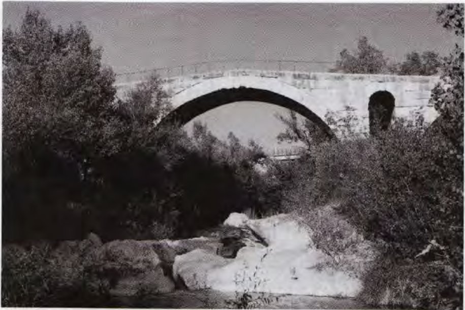
Fig. 1.7 - Pont Julien sur le Coulon près d'Apt (photo G. Scemama).
