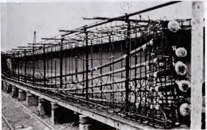
Fig. 4.9 - Vue du câblage d'une poutre (photo SETRA).
