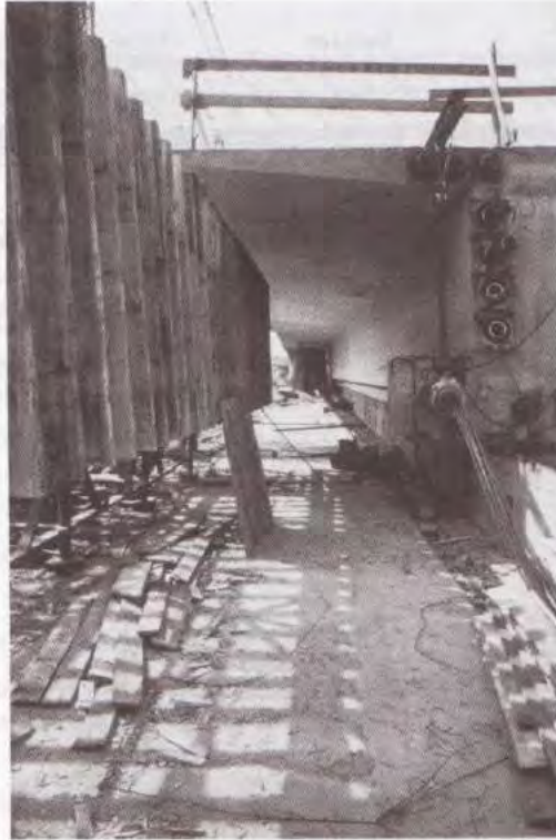
Fig. 6.18 - Poussage d'un pont par traction (photo JAC).
