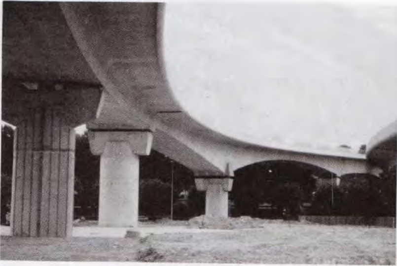
Fig. 3.5 - Ouvrage bien proportionné et de bonne qualité d'aspect (photo SETRA).
