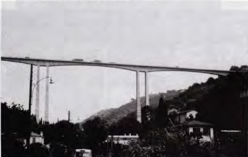
Fig. 3.14 - Le viaduc du Magnan (photo SETRA).
