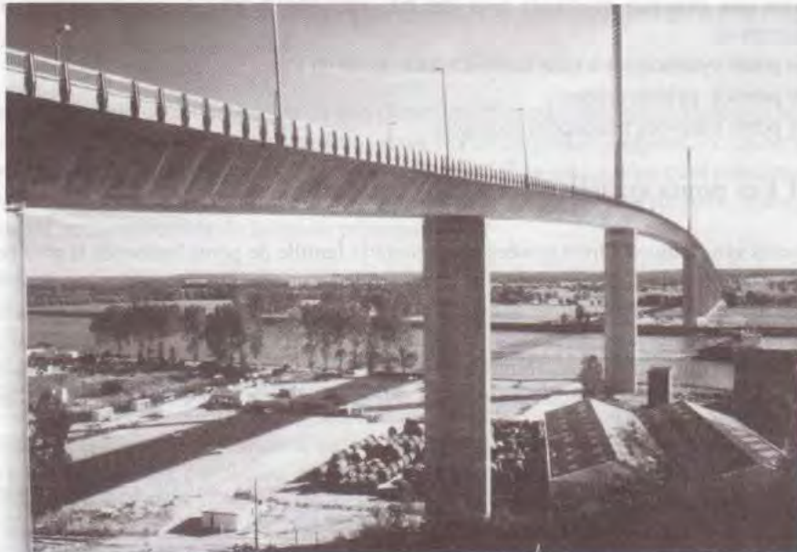
Fig. 8.4 - Le pont de Brotonne sur la Seine (photo Campenon-Bernard).
