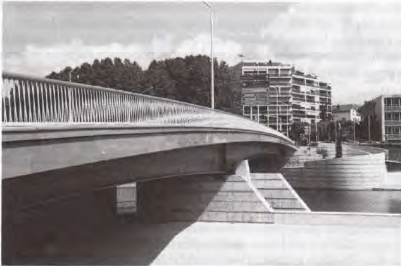
Fig. 7.7 - Pont sur le Doubs à Besançon. Remarquer l'épaisseur variable de la semelle inférieure des poutres (photo JAC).
