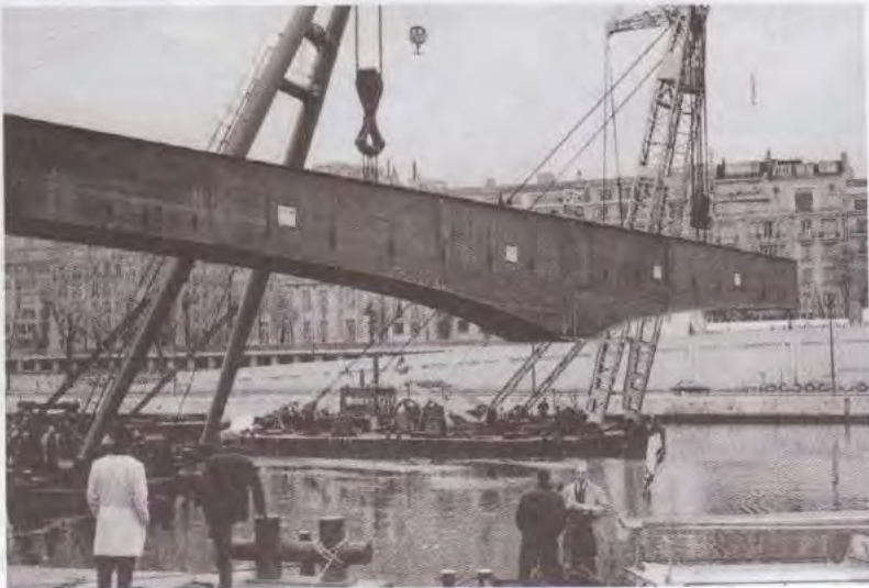
Fig. 7.32 - Construction du pont de l'Alma à Paris (photo SETRA).
