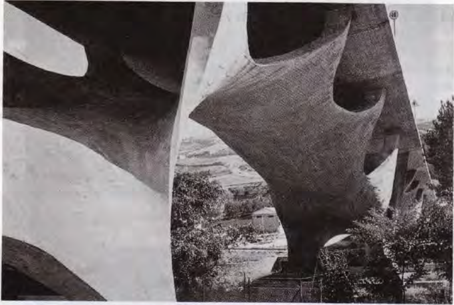
Fig. 3.1 - Pont sur le Basento en Italie (photo Industria Italiana del Cemento).
